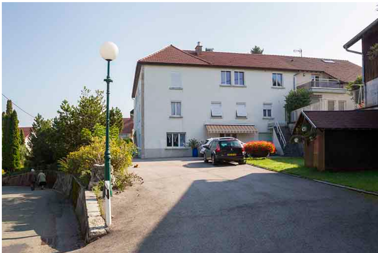
Façade latérale droite.
