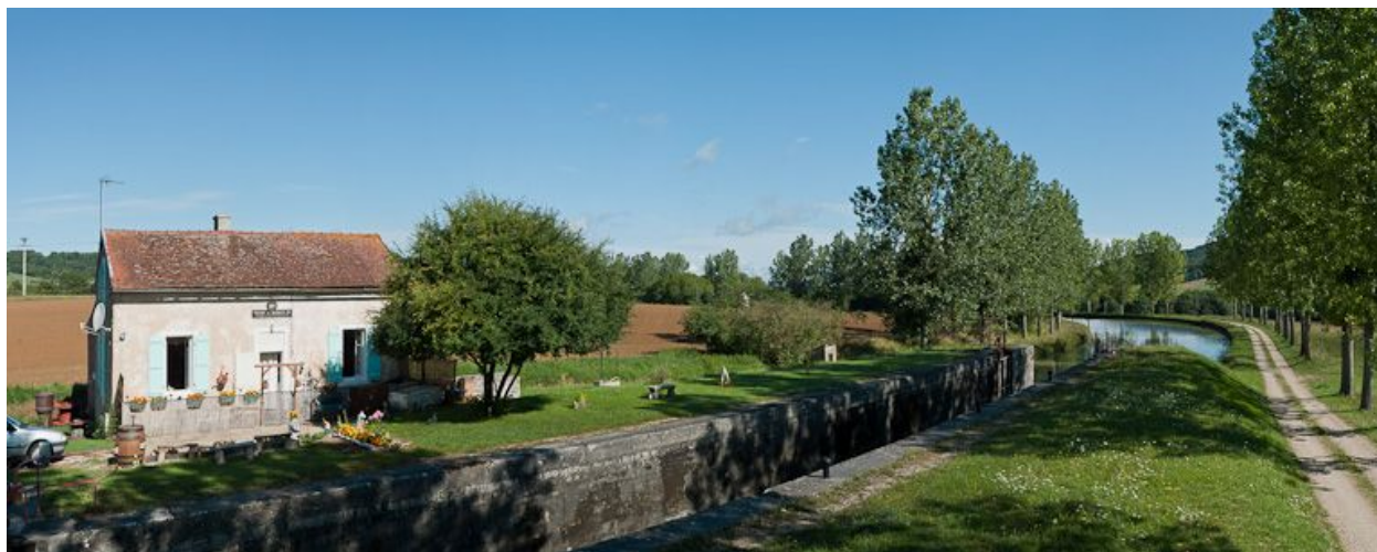
Vue d'ensemble du site d'écluse.
