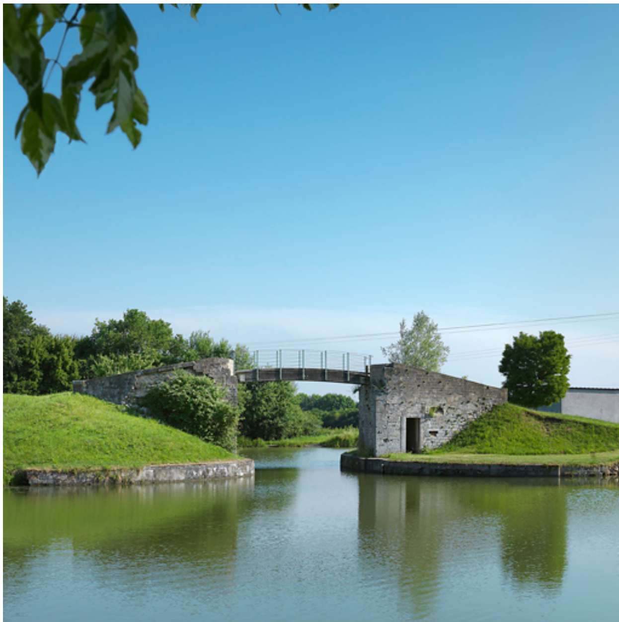
Vue de la passerelle haute, de face.
