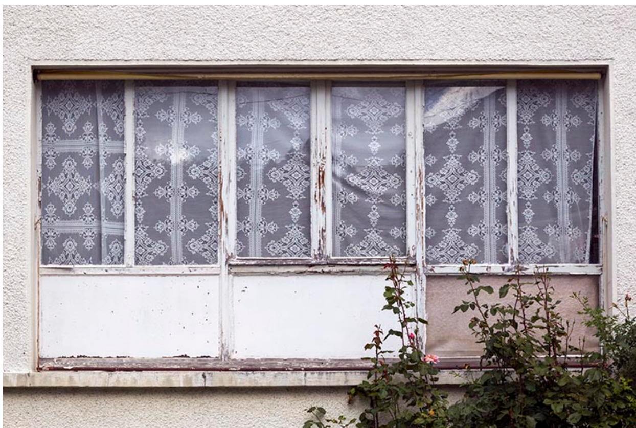
Façade antérieure : fenêtre d'atelier au rez-de-chaussée.
