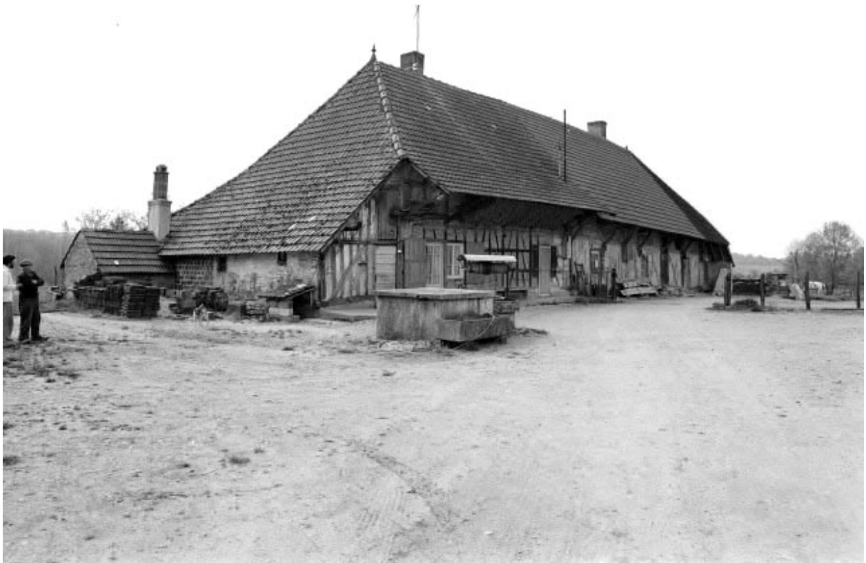
Bâtiment d'habitation : vue d'ensemble.
