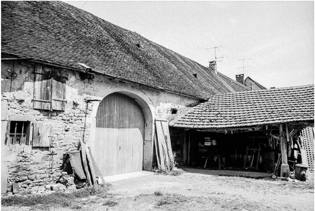
Fermes situées 324-326 rue d'Oisenans : bâtiments d'exploitation.
