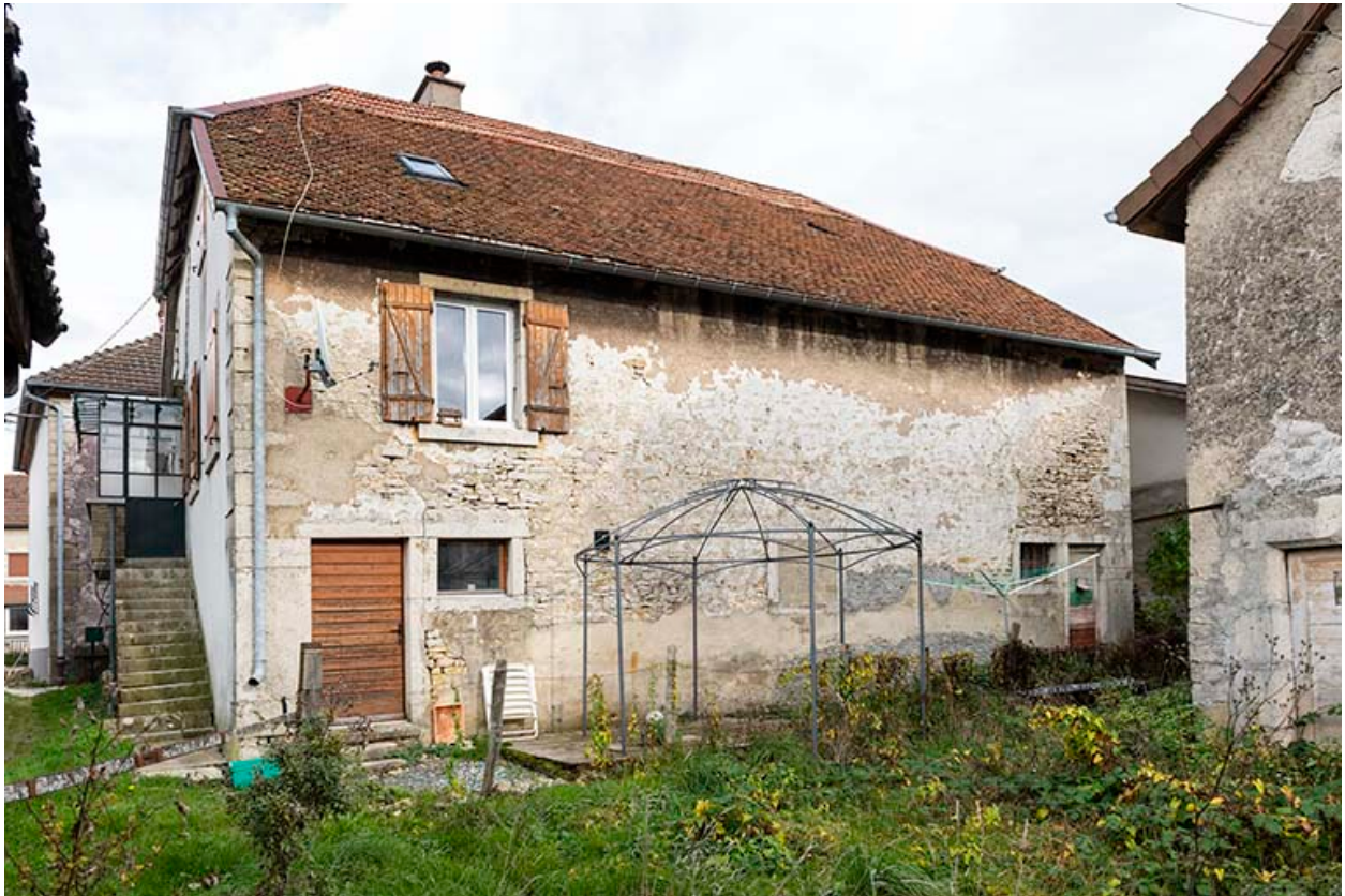
Grange : façade postérieure.
