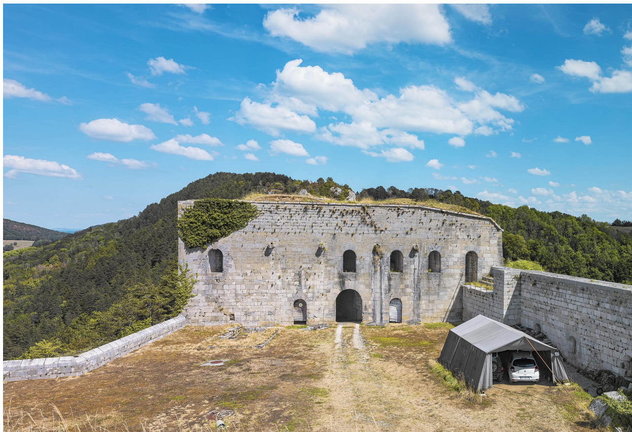
La façade postérieure.
