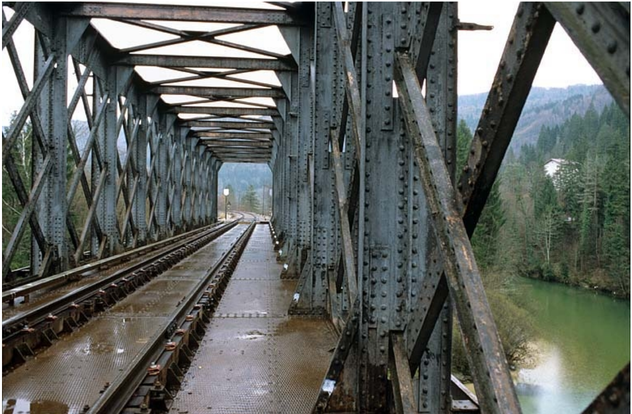
Charpente métallique, tablier et voie.
