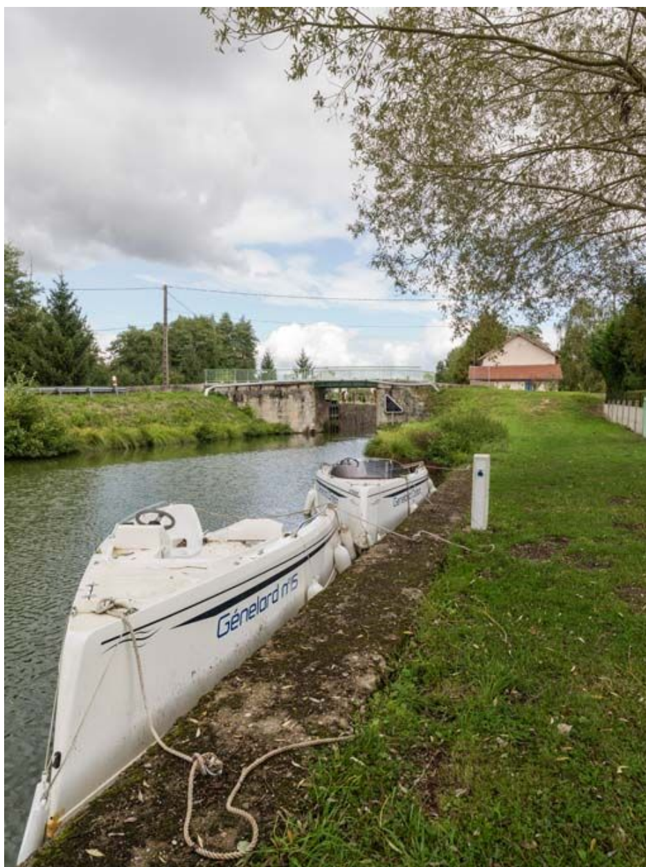
Vue d'ensemble du pont.
