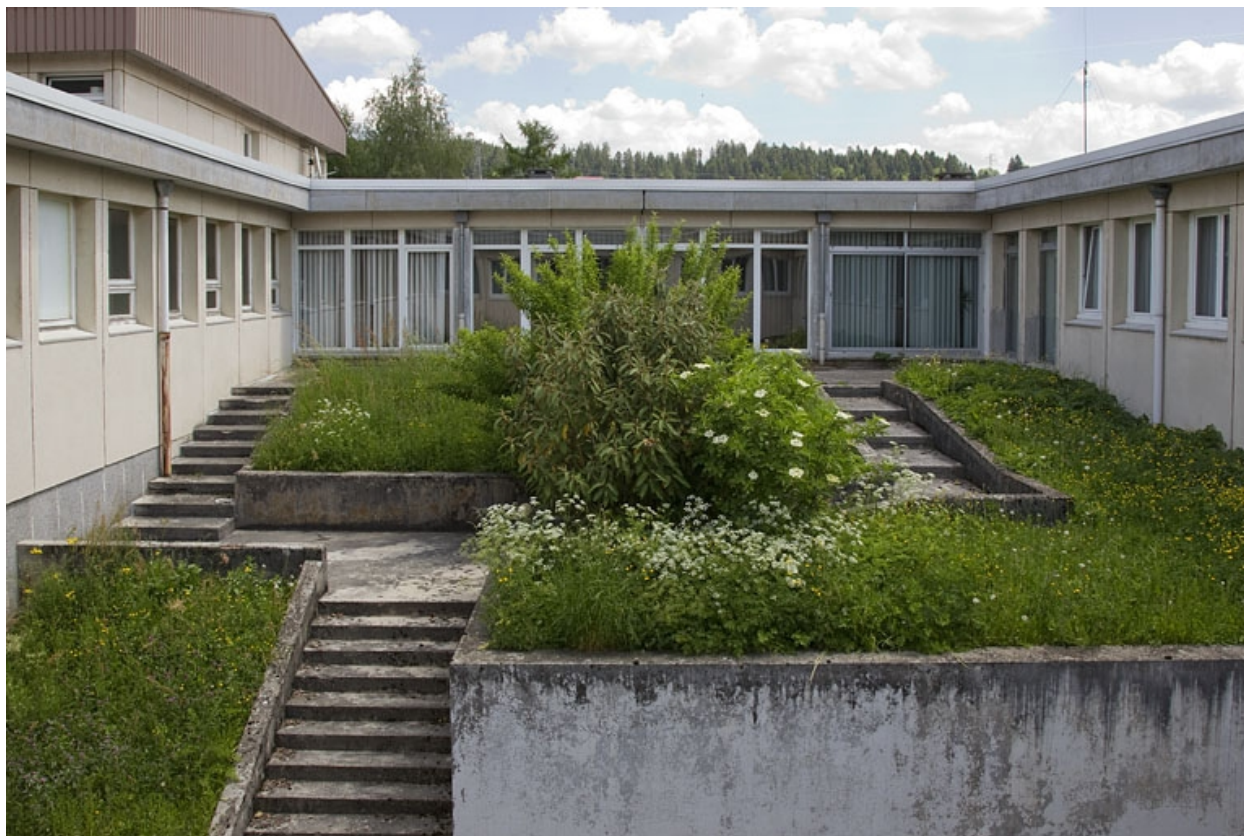
Bâtiment de l'administration : patio.
