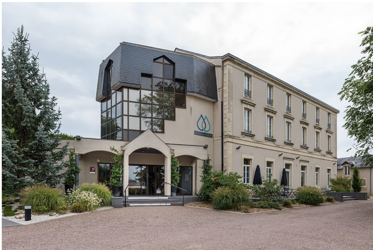
Façade après les travaux de modernisation de 2017.
