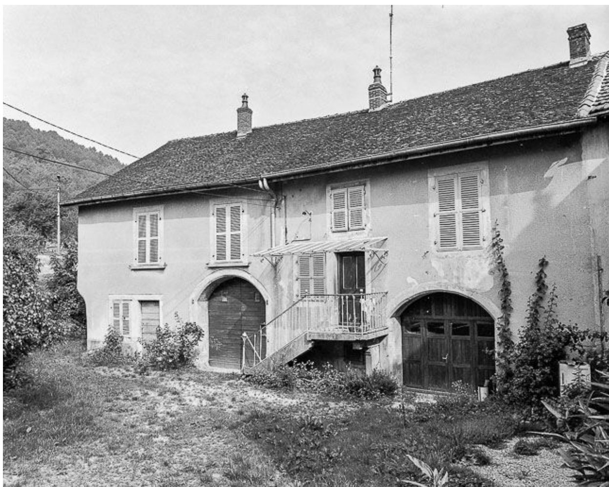
Maison de vigneron située à Vaux-sous-Bornay.
