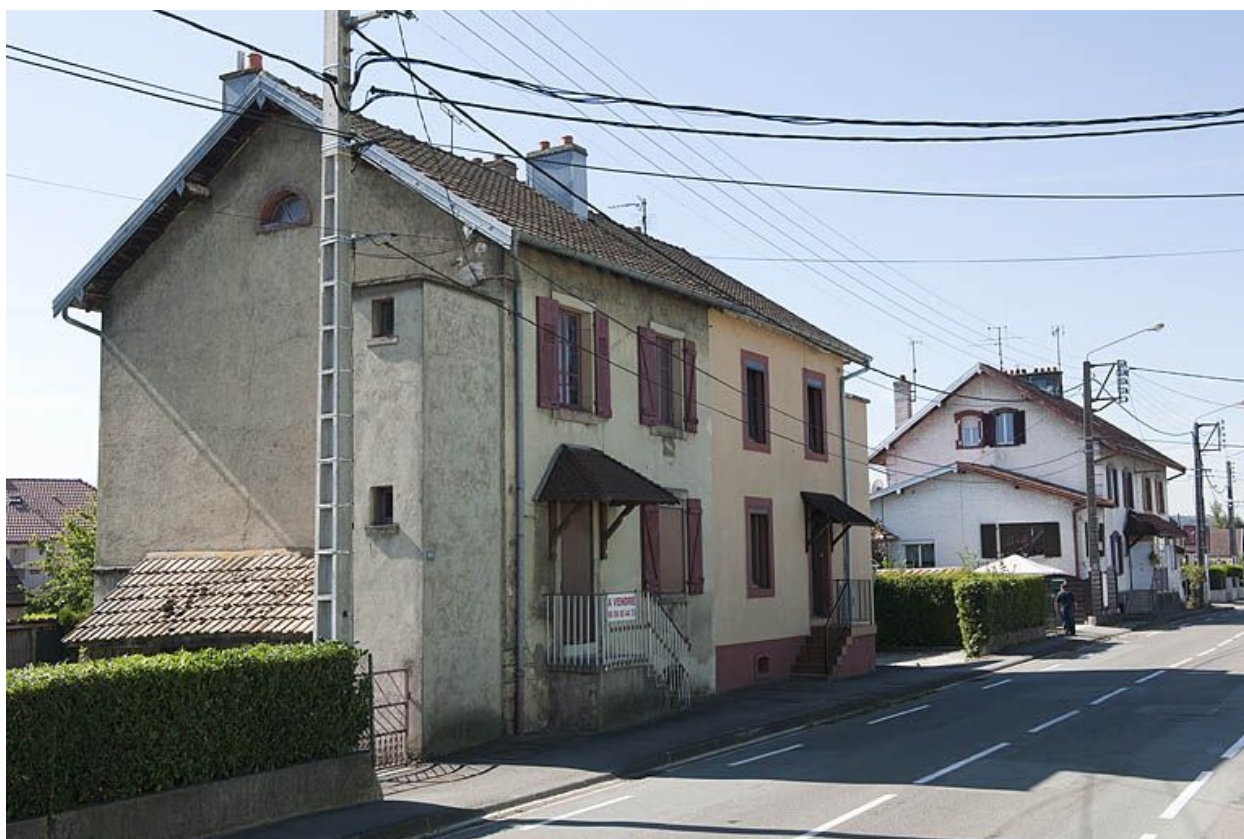
Deux habitations de 4 logements rue des Mines.
