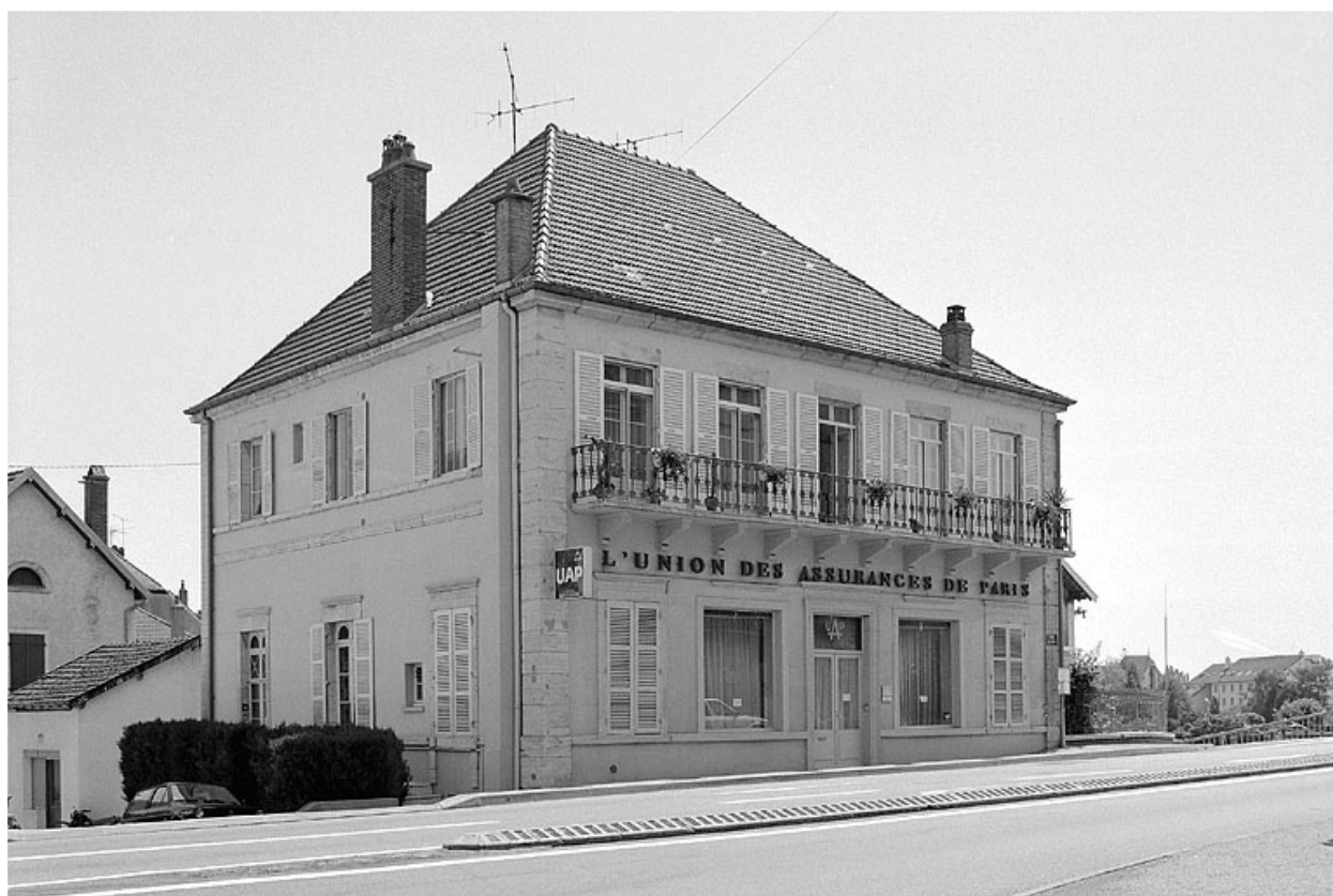
Maison située 2 avenue Couyba.
