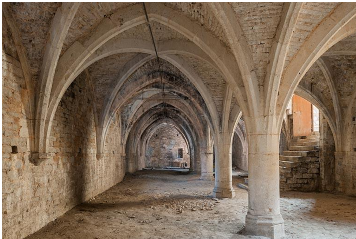
Vue générale de la cave voutée sur croisées d'ogives
