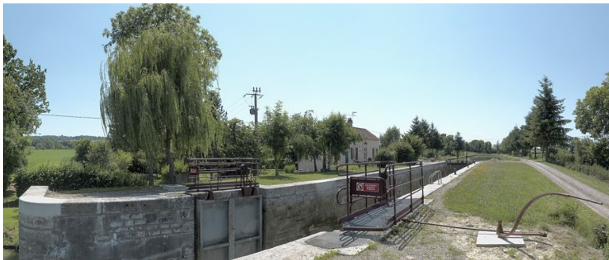
Le site d'écluse vu d'aval.
