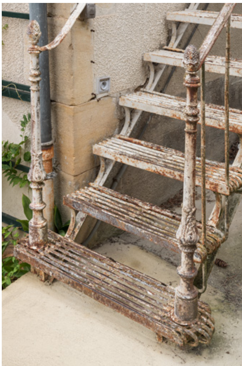
Escalier extérieur conduisant à l'étage, détail.
