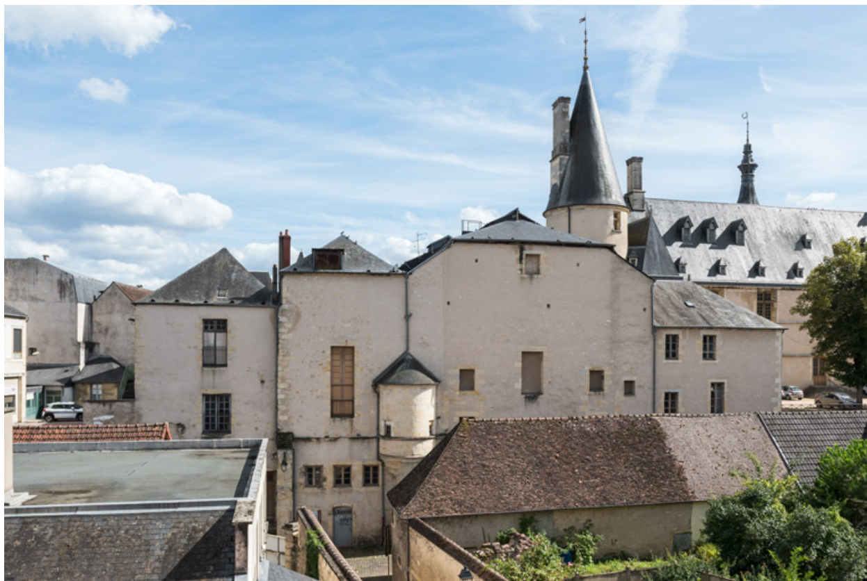
Vue d'ensemble, depuis le nord (façade postérieure).
