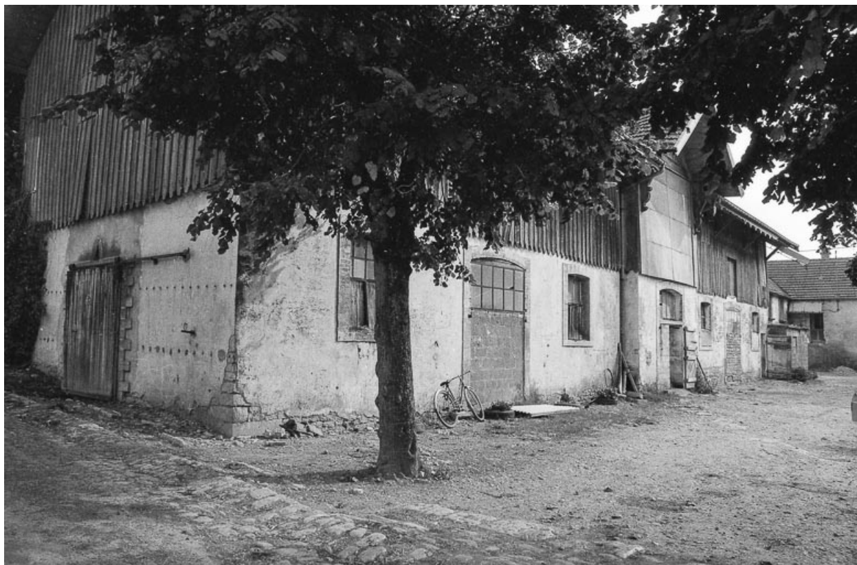
Maison située rue de l'Eglise.
