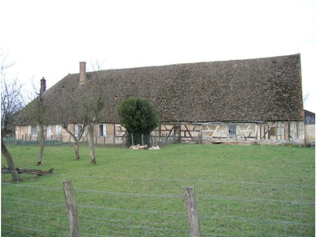
Vue d'ensemble de la façade.
