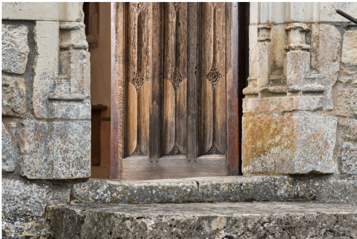
Piédroit, détail de la partie inférieure.
