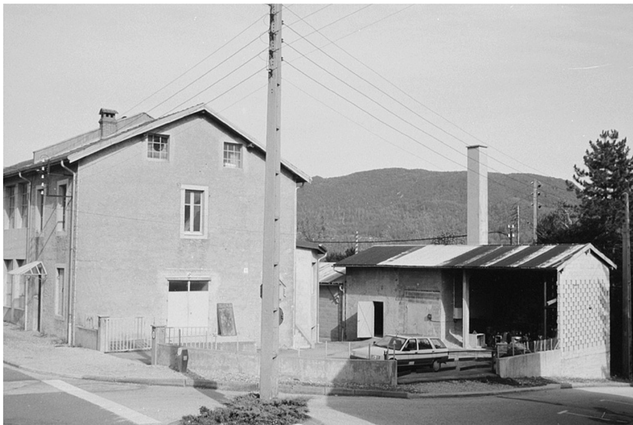
Façade latérale droite et chaufferie.
