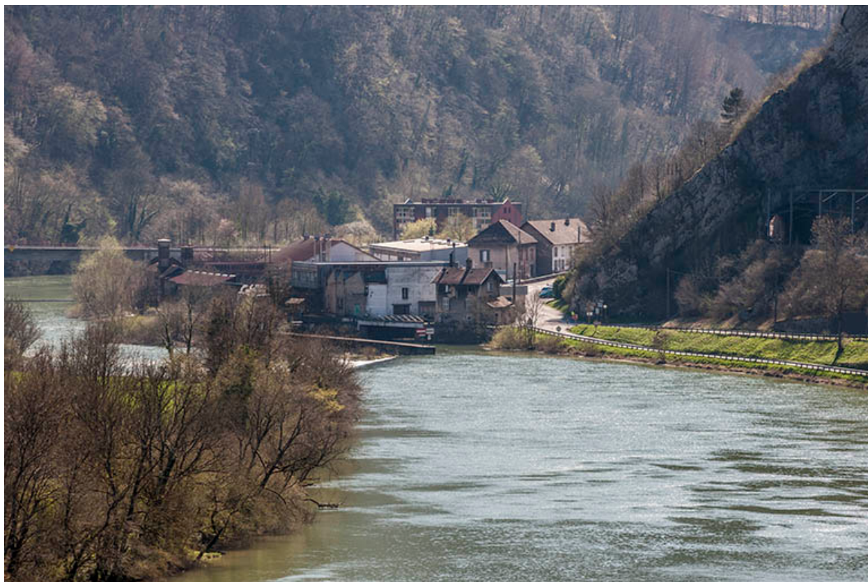
L'usine vue depuis l'amont.
