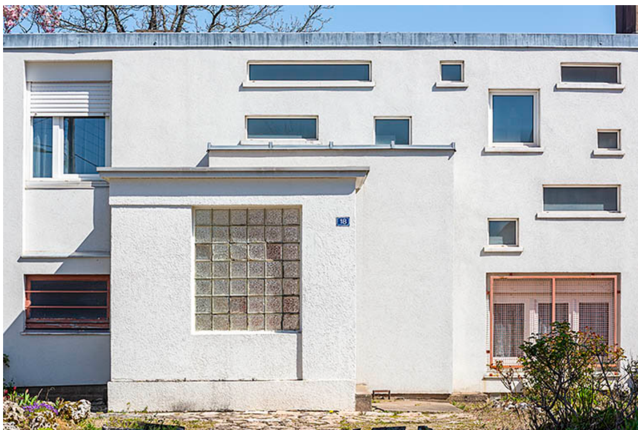
Presbytère. Détail de la façade sud-ouest.
