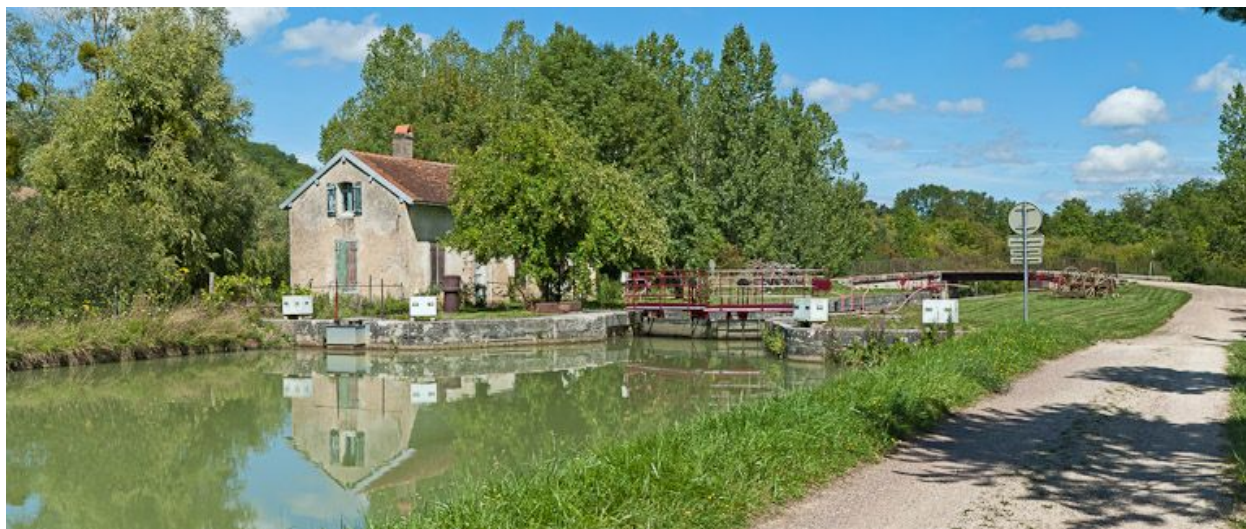
Vue d'ensemble du site d'écluse.
