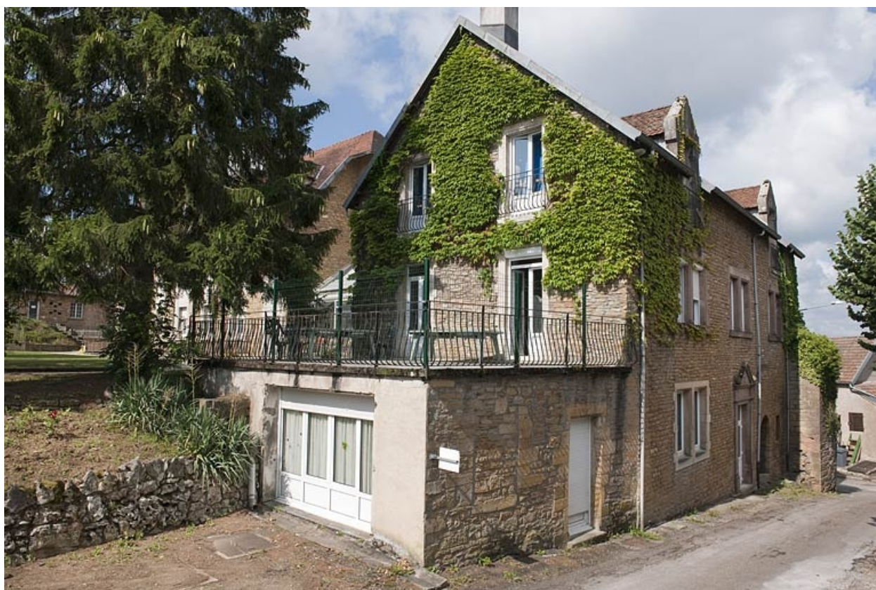
Bâtiment (A), vue de trois quart gauche.
