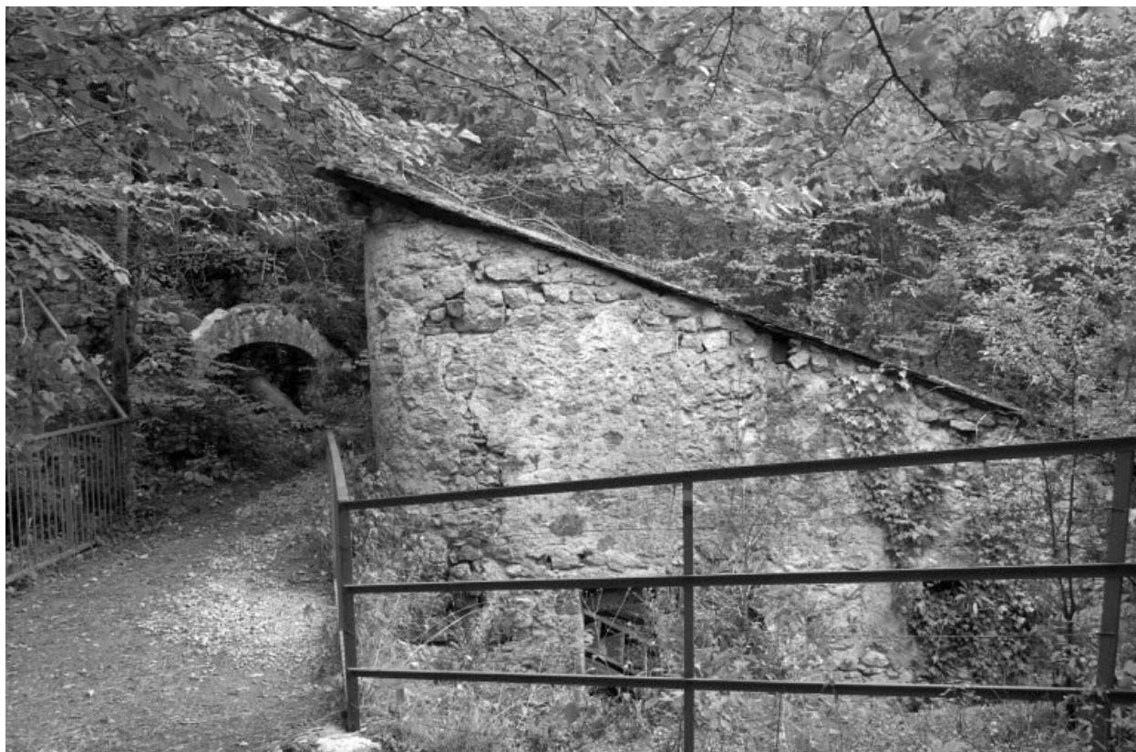
Site de la cascade : bâtiment d'eau.
