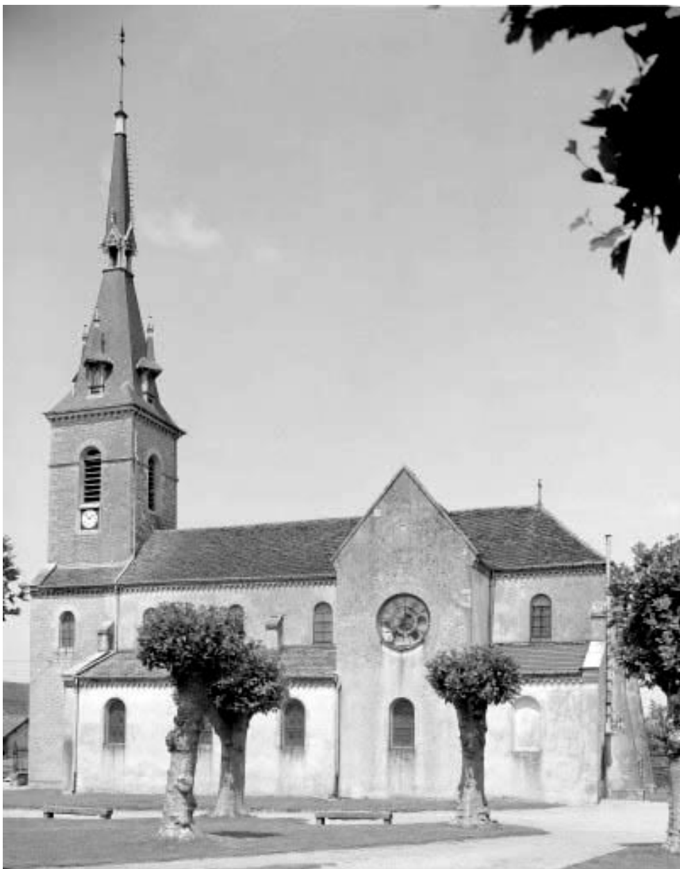
Façade sud en 1975.
