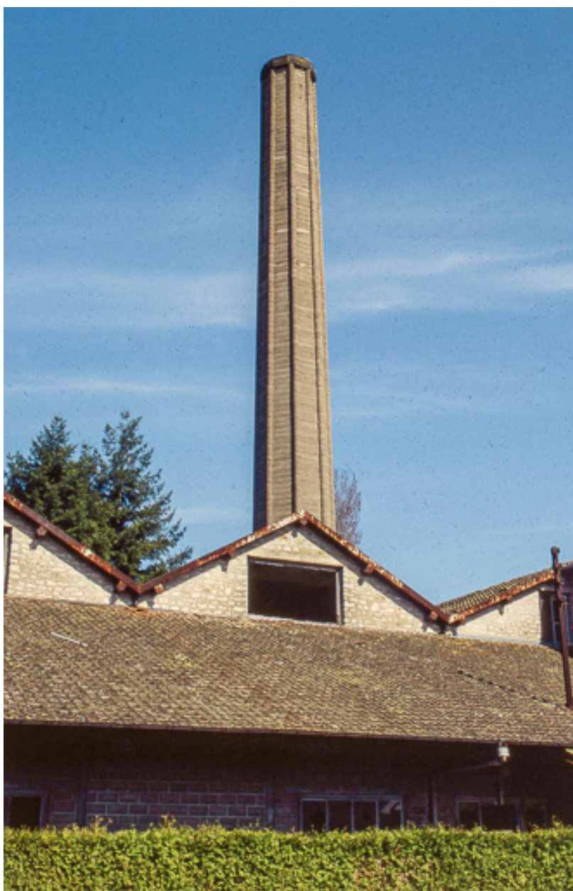
Quai couvert, magasins industriels et cheminée.
