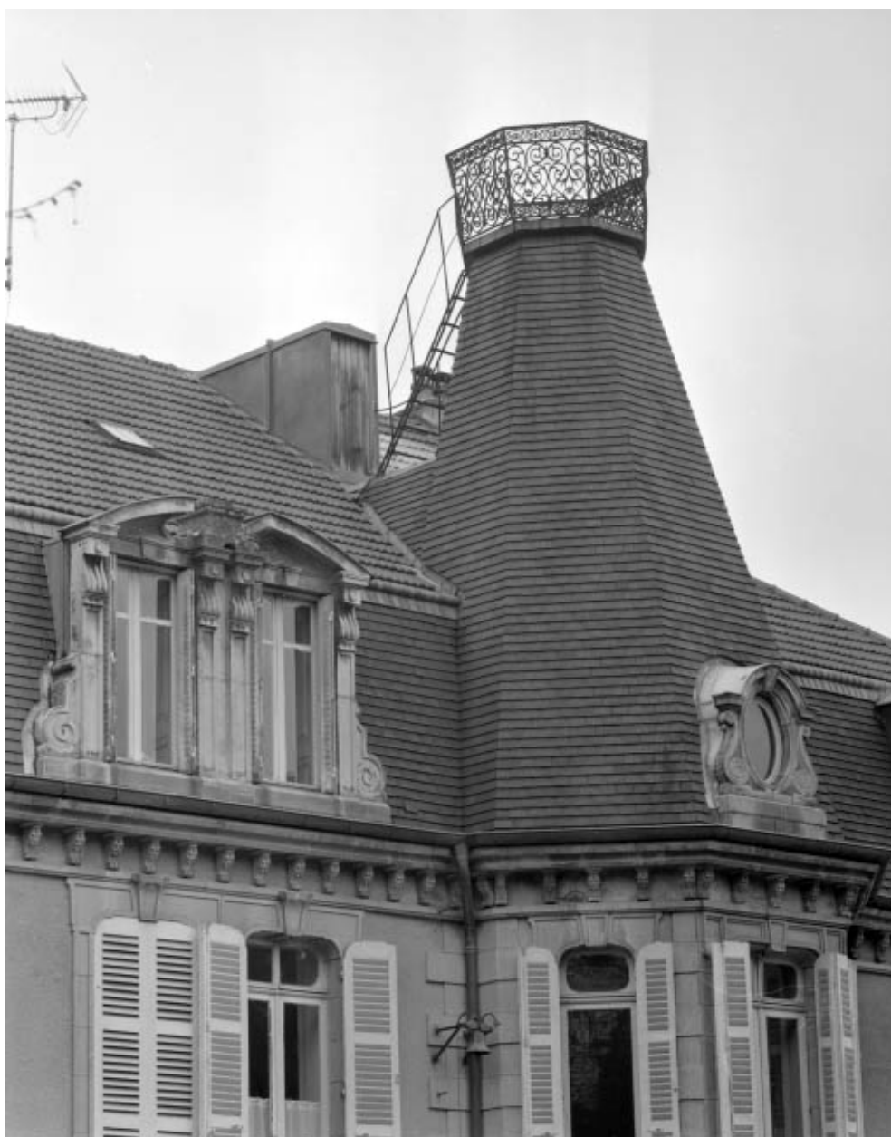
Château Béthanie : toiture de la tourelle d'escalier.
