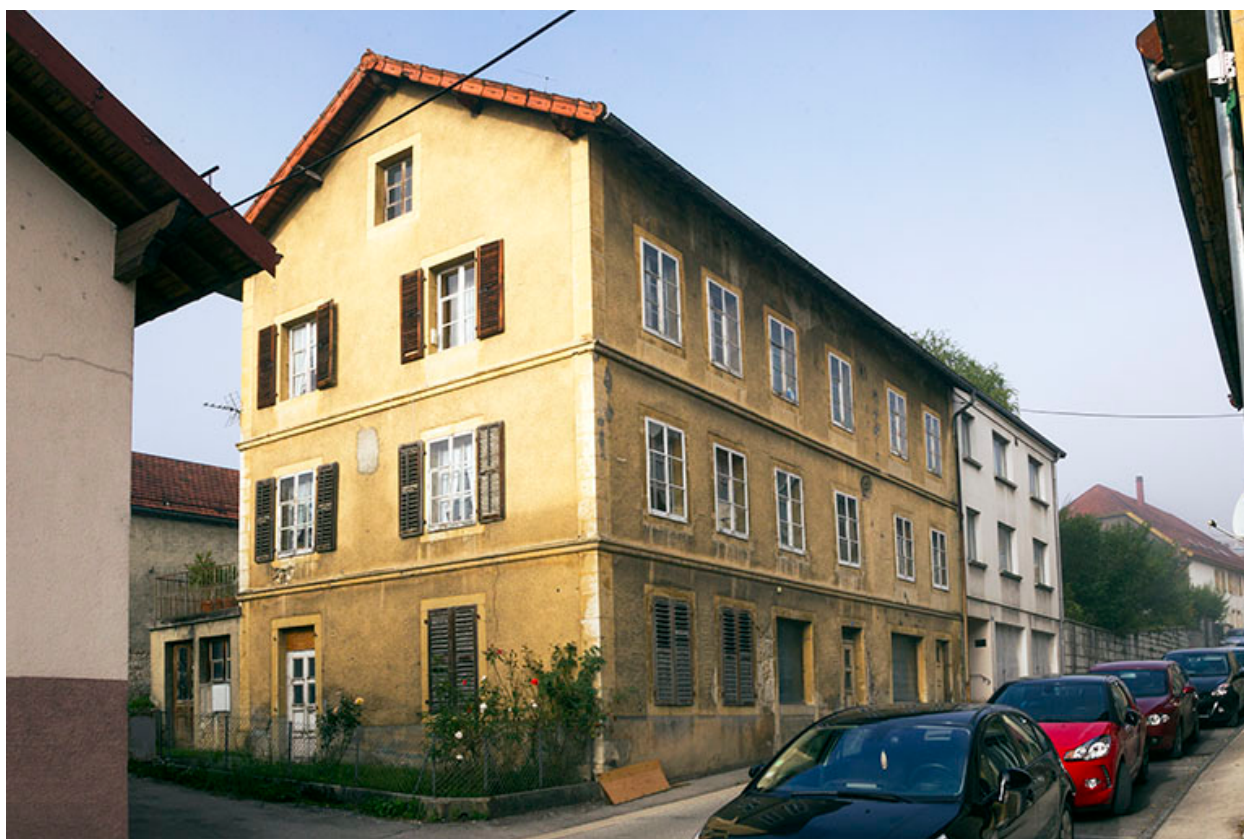
Façades antérieure et latérale gauche.
