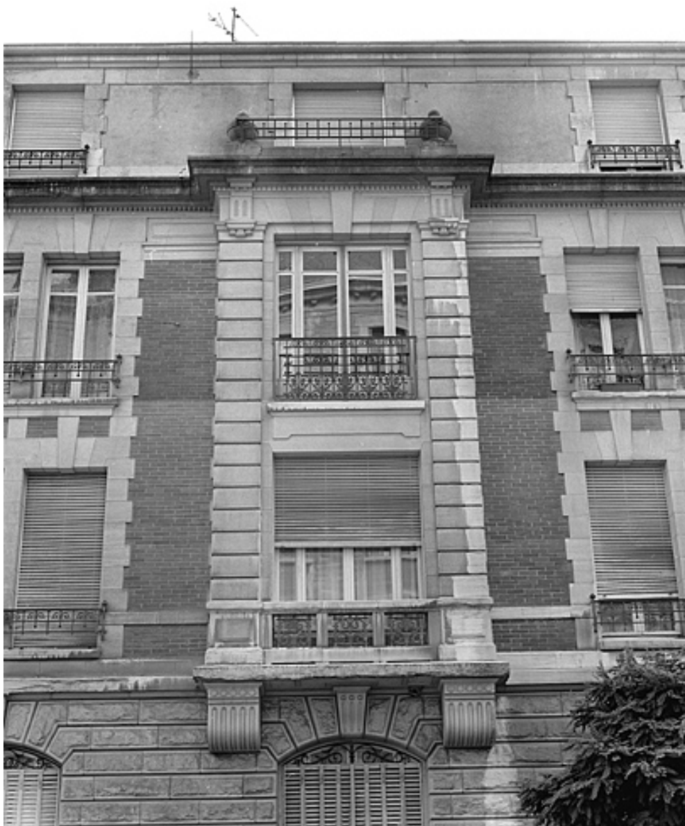
Façade antérieure, détail de l'élévation.
