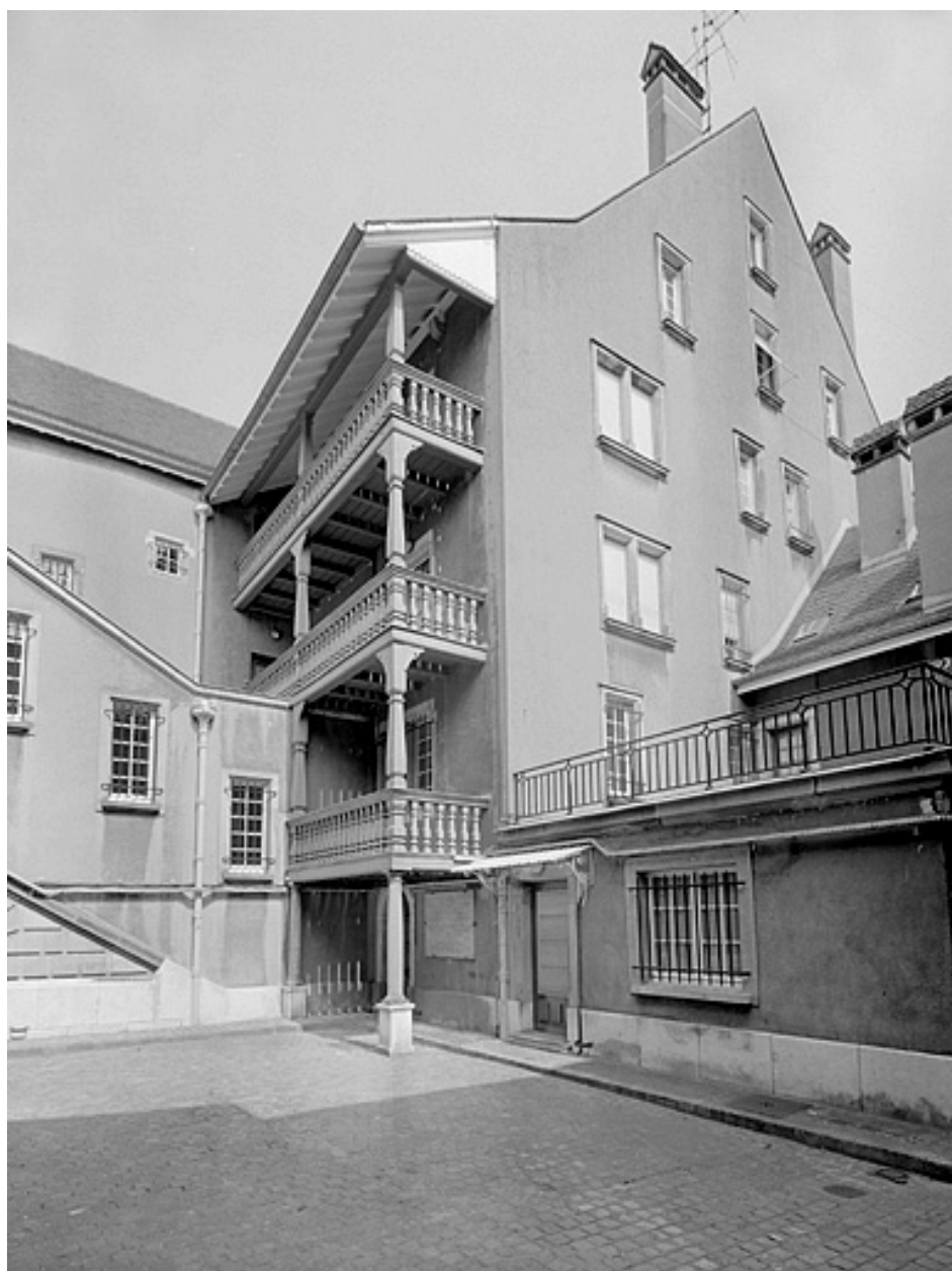
Façade sur cour.
