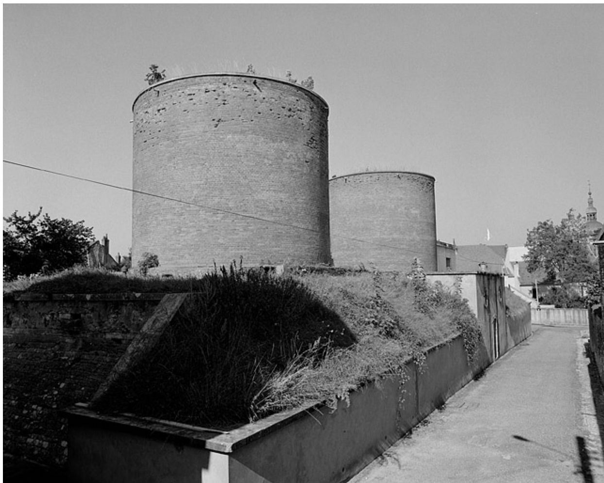
Vue des réservoirs depuis le revers.
