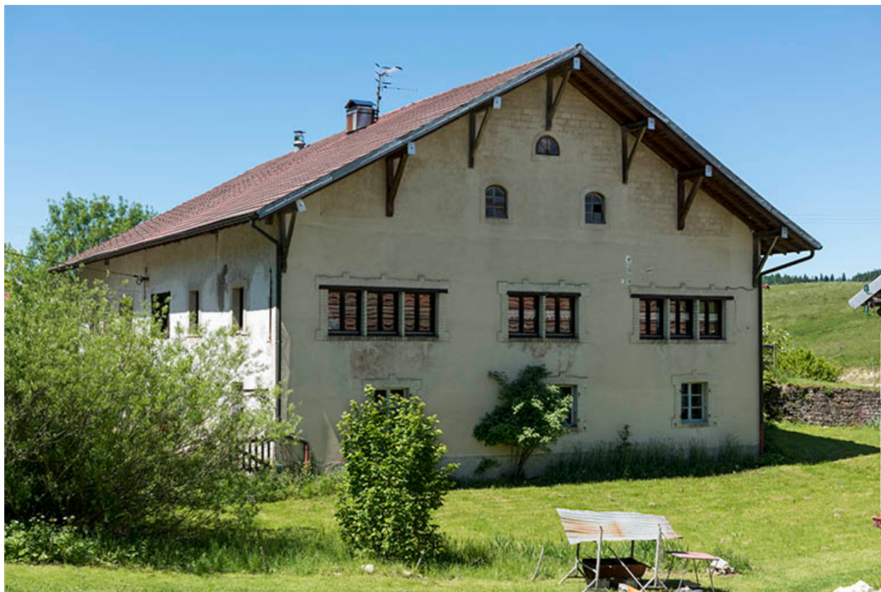
Façade latérale droite, de trois quarts gauche.
