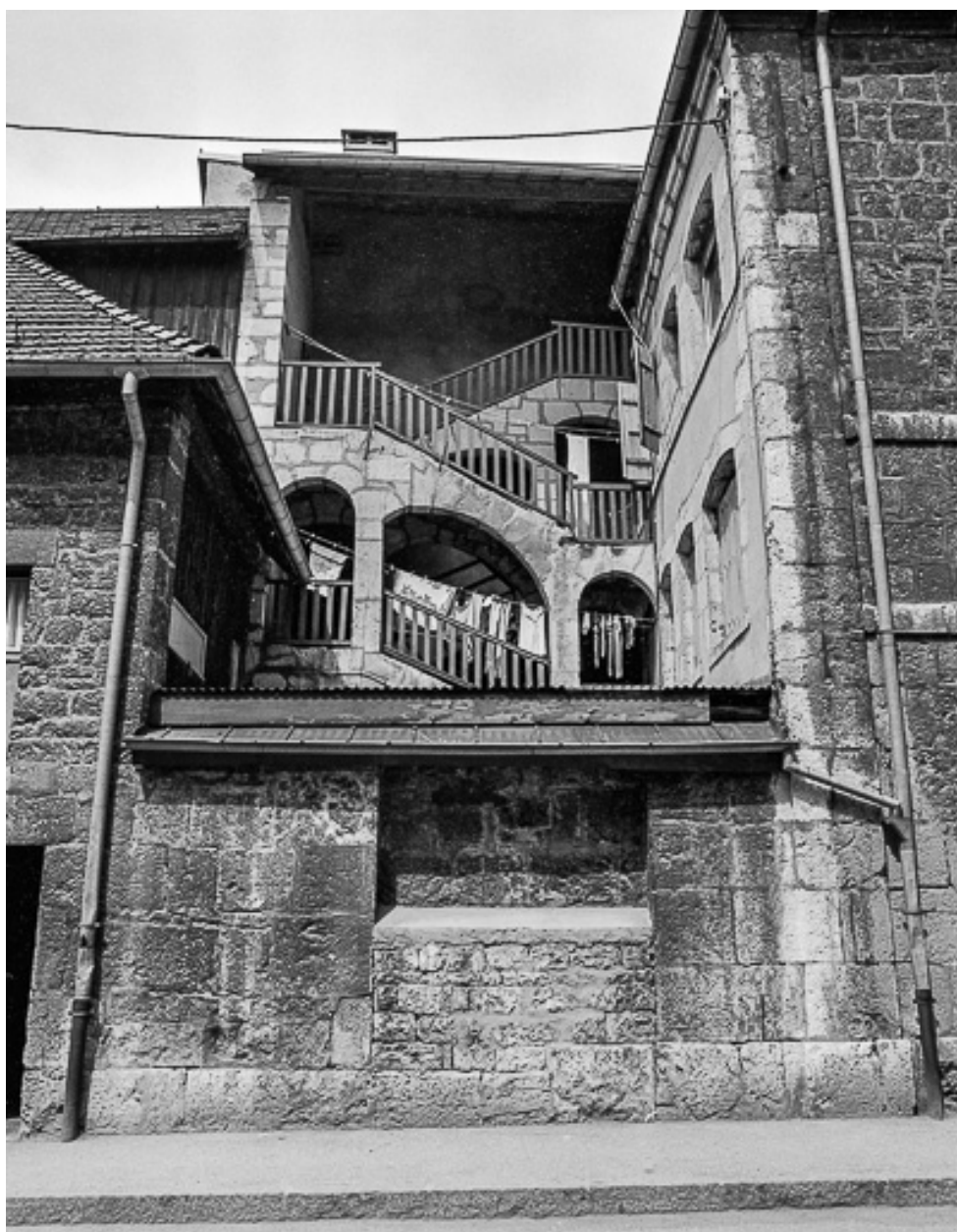
Escalier sur cour.
