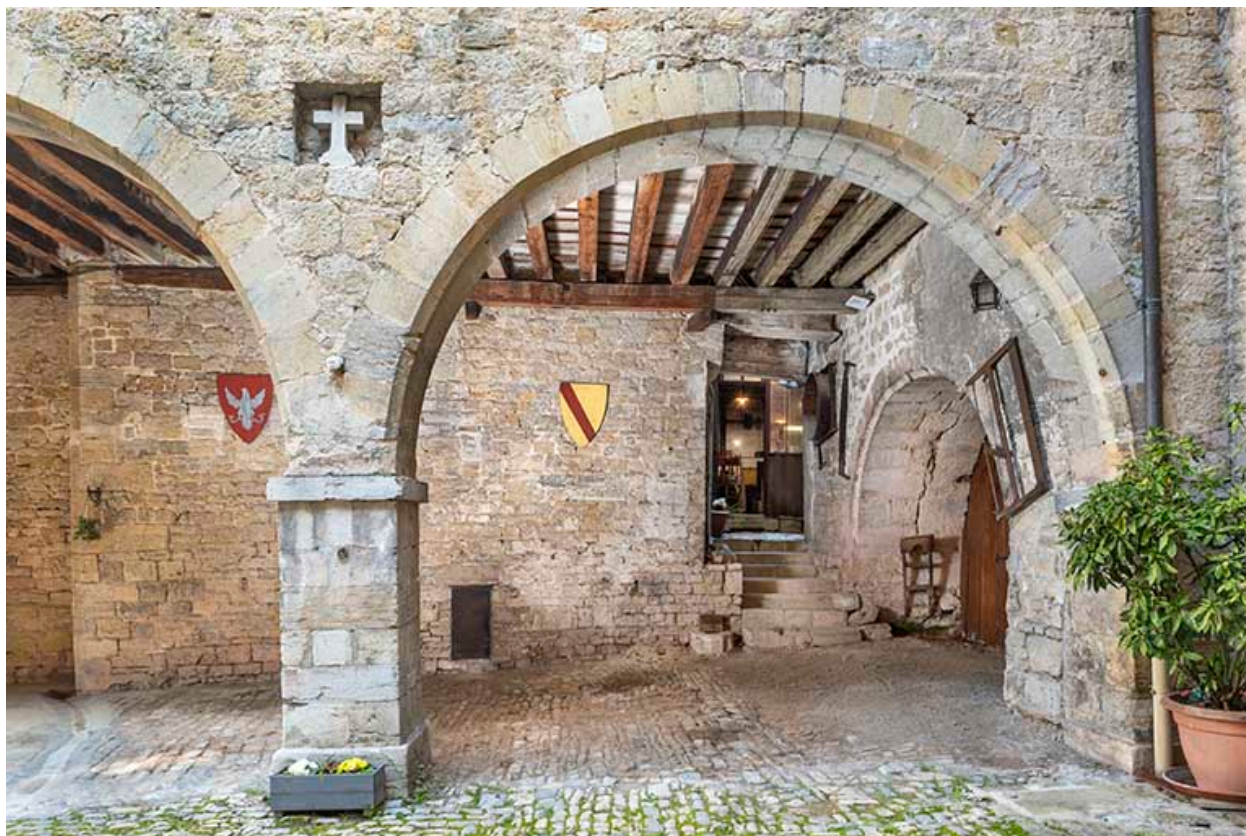
Arcades du passage couvert nord.
