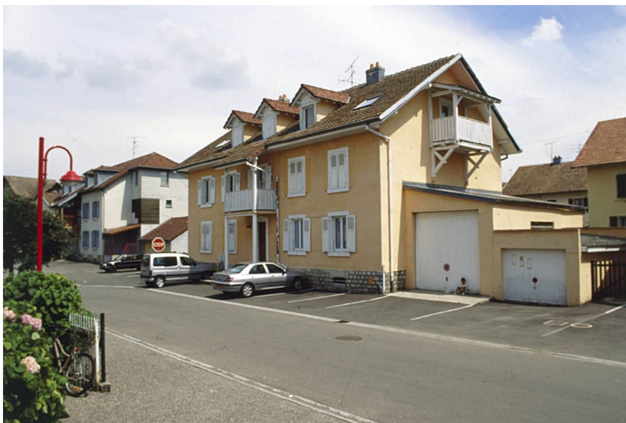
Logements collectifs rue Kléber.
