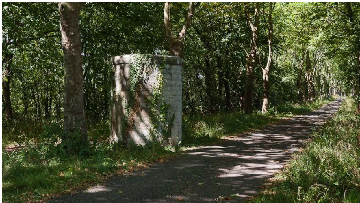
Vue d'un puits d'aérage du tunnel.
