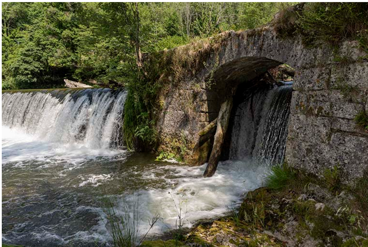
Extrémité du barrage rive droite.
