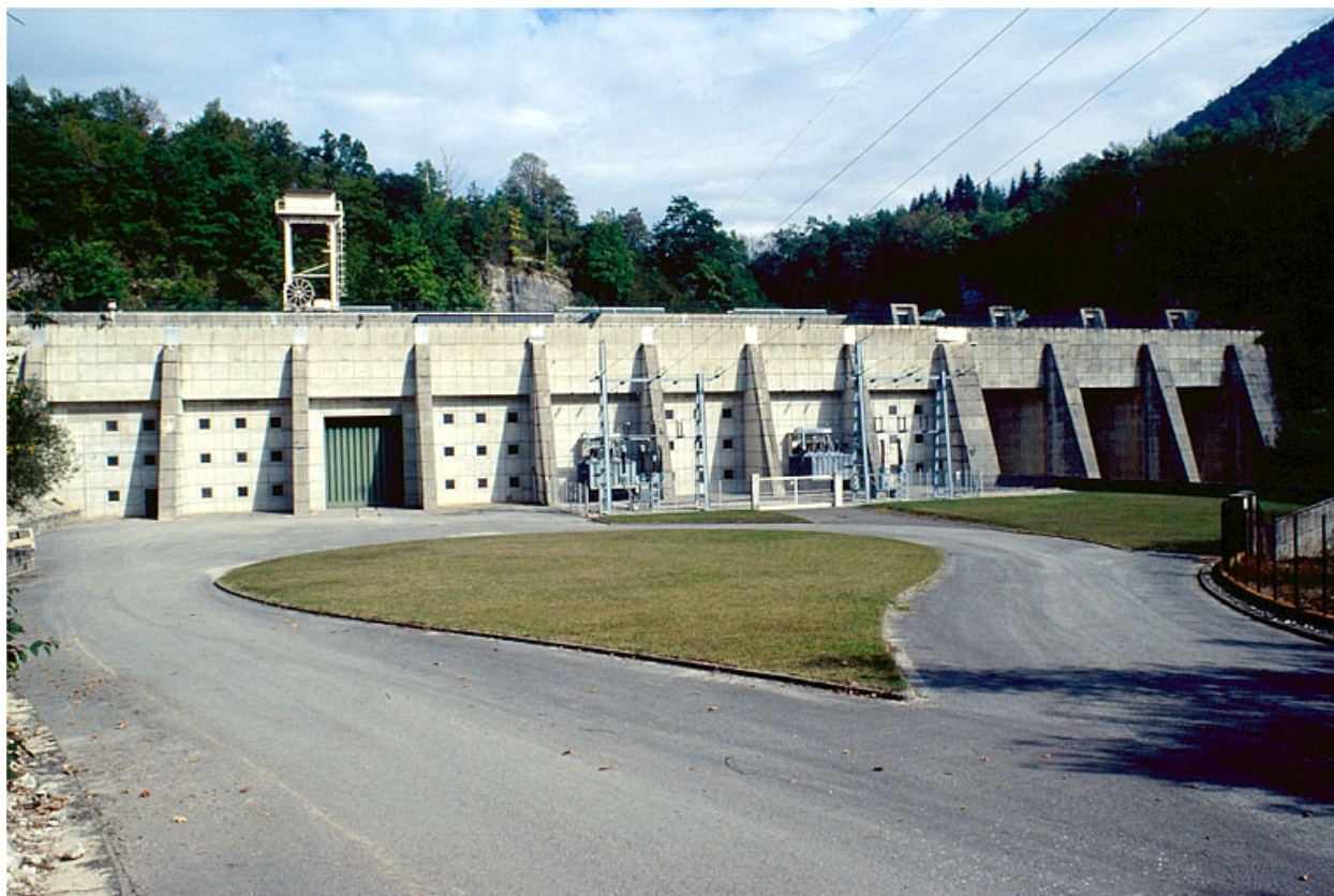
Centrale hydroélectrique du Saut-Mortier, Cernon.
