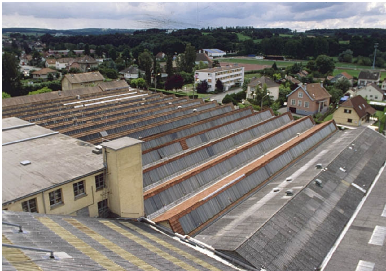
Toitures des ateliers de fabrication en rez-de-chaussée.
