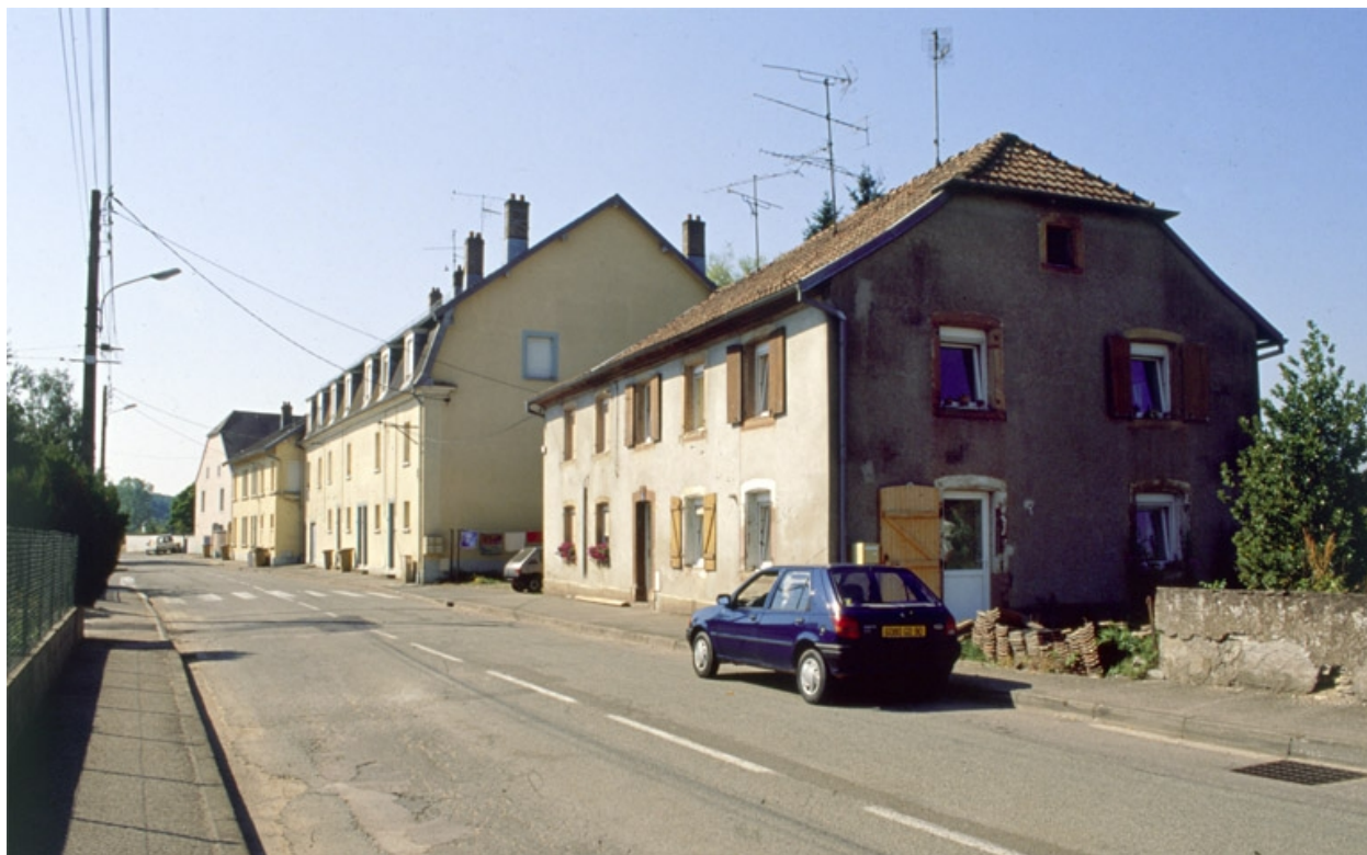
Logements et bureaux depuis la rue d'Andelnans.
