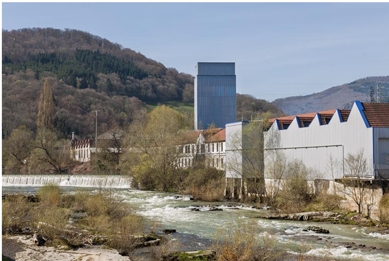
Usine rive gauche. Vue depuis le pont.
