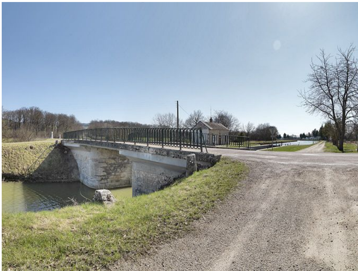
Le pont vu d'aval.
