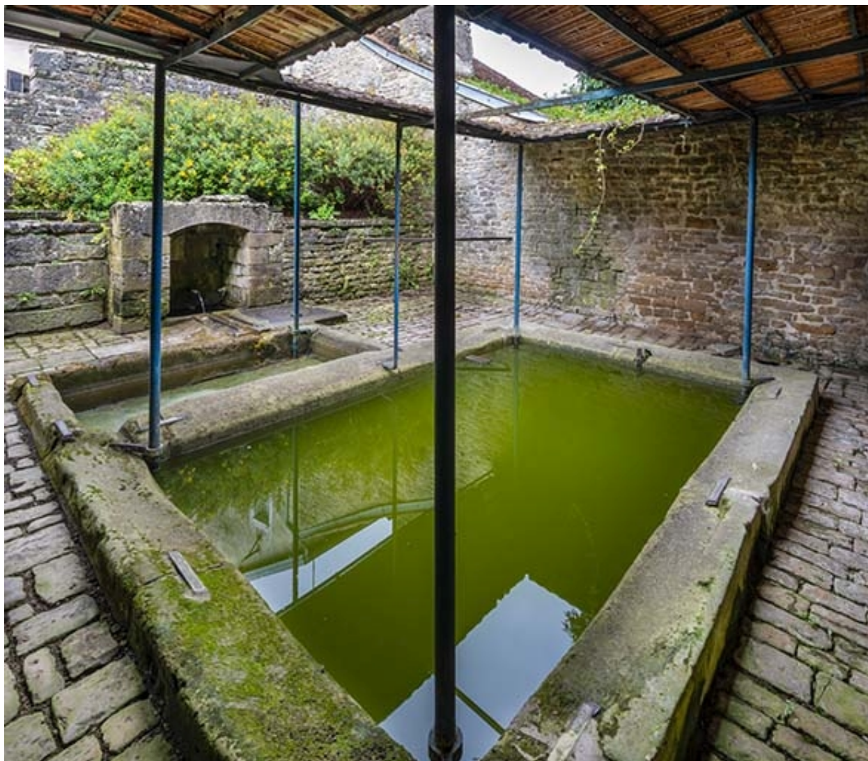
Vue intérieure des bassins.
