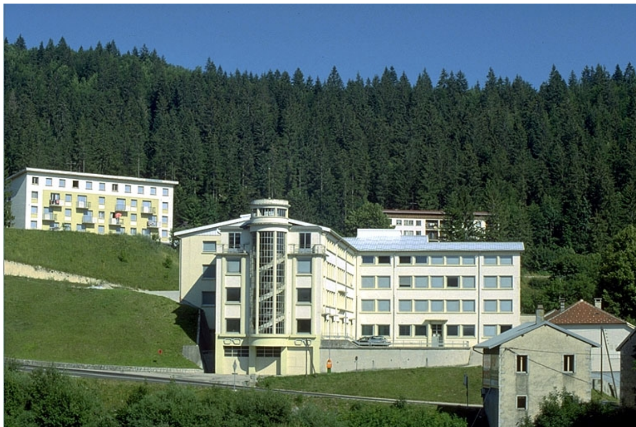
Morbier : usine d'horlogerie Girod, 83-93 route Blanche.
