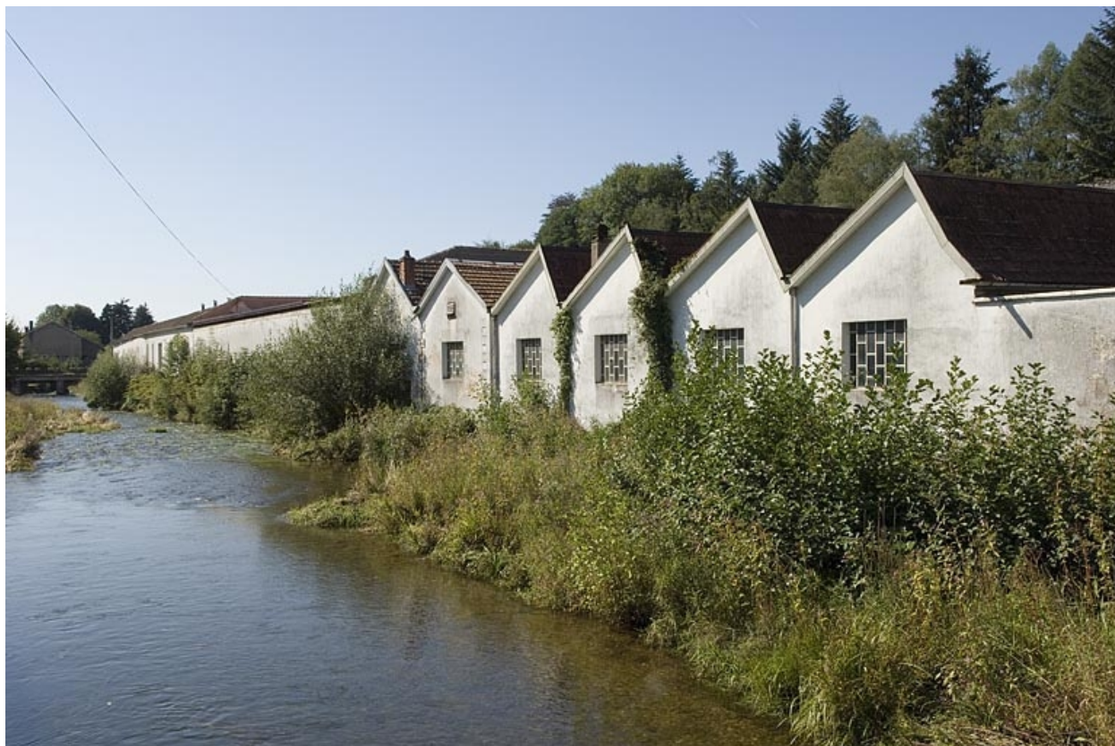
Magasins industriels le long de la Combeauté.
