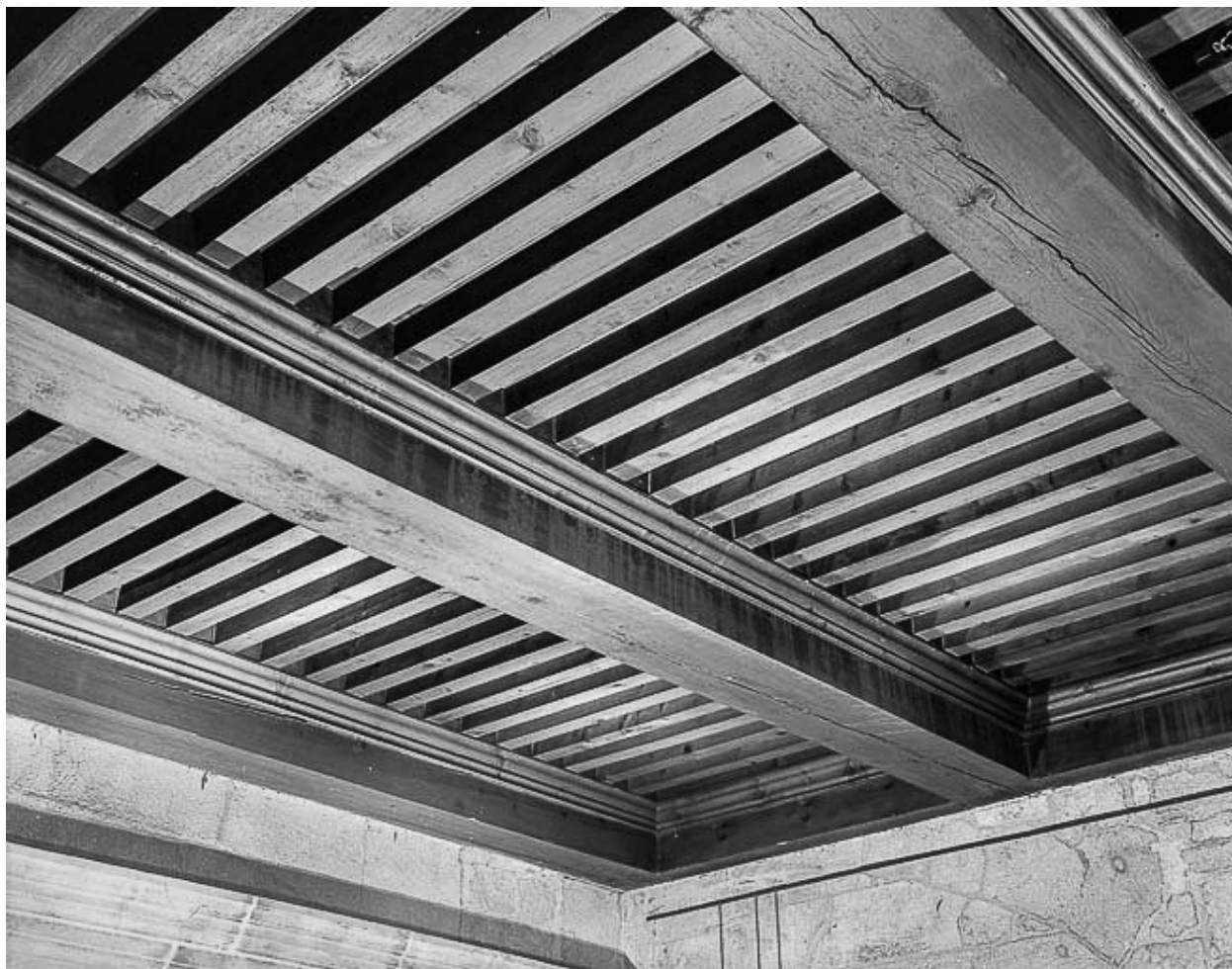
Vue du plafond.
